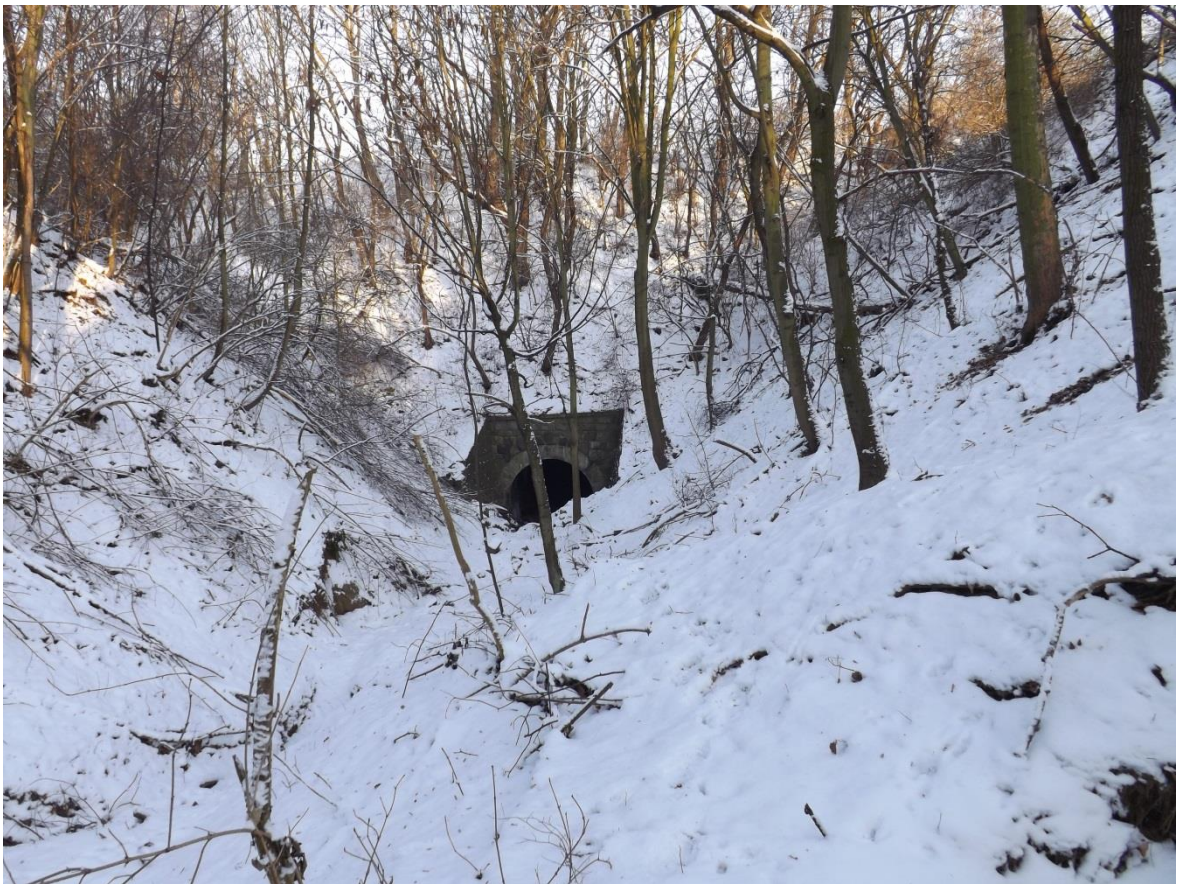
Obr. 8 Propustek pod železniční tratí
