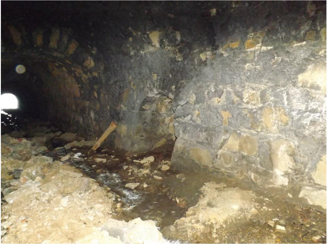
Obr. 9 Interiér propustku, uprostřed vyústění štoly
