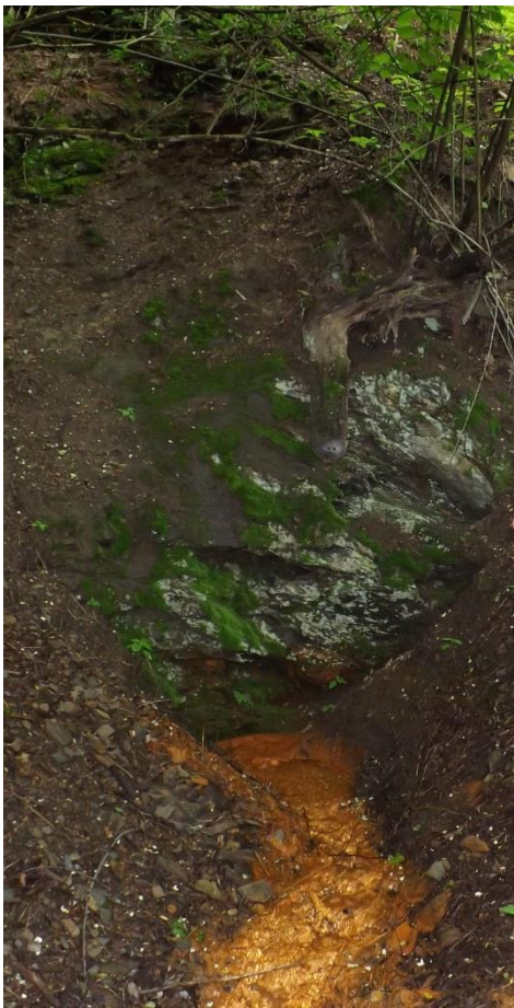
Obr. 6 Zavalené ústí hlavní štoly
