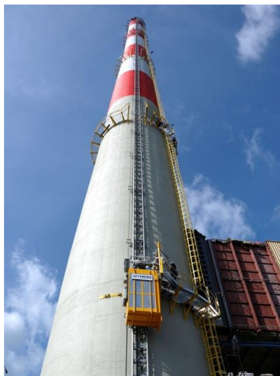
Obr. 7 - Komínový výtah – Varšava [6]
