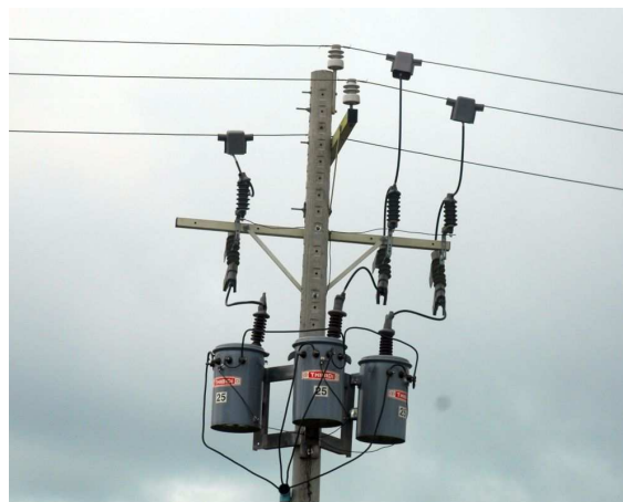
Obr. 1 Jednofázové distribuční transformátory v síti VN s přímo uzemněným uzlem
