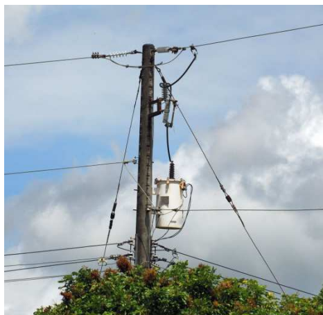
Obr. 1 Jednofázové distribuční transformátory v síti VN s přímo uzemněným uzlem
