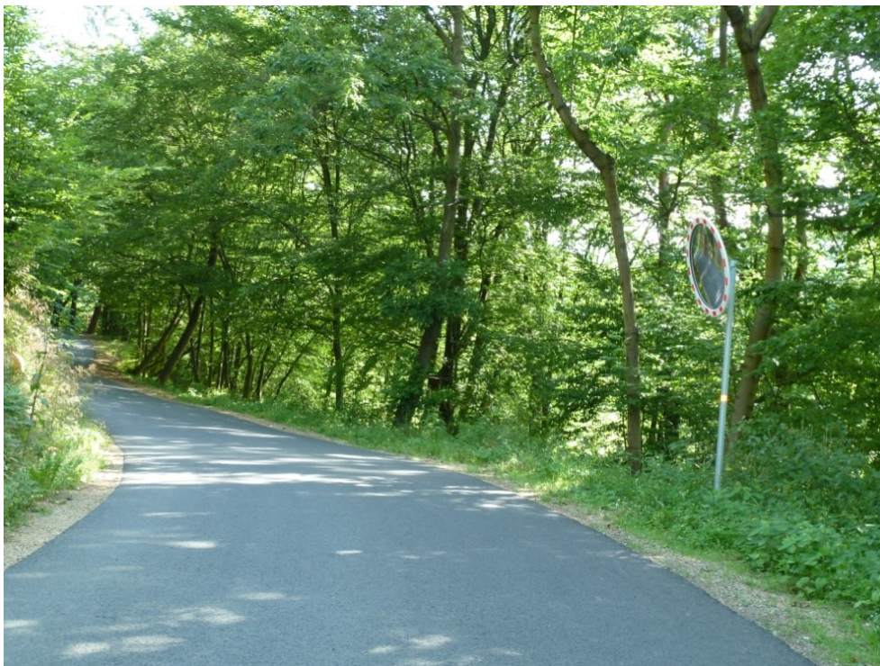
Obr. 49: Oprava místní komunikace Ostrovec – Lhotka
