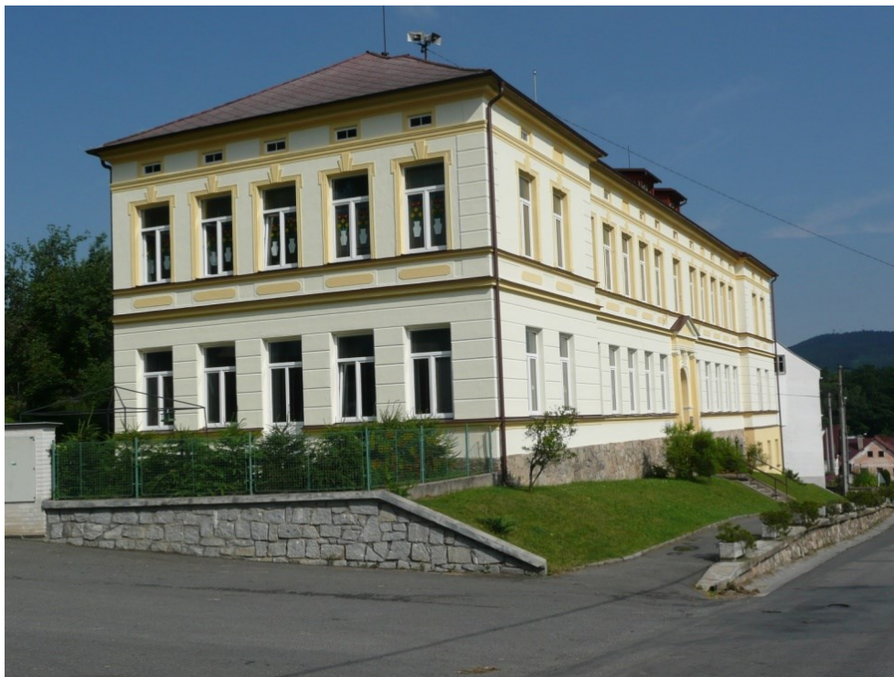
Obr. 47: Oprava Základní školy v Dlouhé vsi
