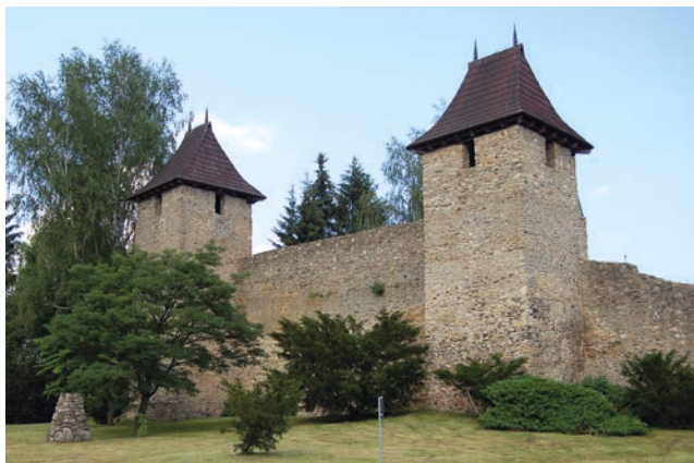
Tachovské městské hradby, pocházející z doby krátce po založení města v 70. letech 13. století, jsou z velké části dochovány dodnes. (CC licence)
