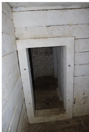
Vnitřek jedlinského bunkru. (Foto Lukáš Funk, 2013)
