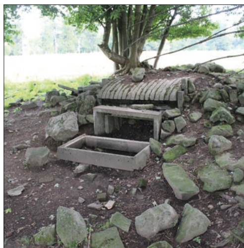
Kulometný bunkr z železobetonových prefabrikátů na obranné linii PS u zaniklé obce Pavlův Studenec. (Foto Lukáš Funk, 2013)
