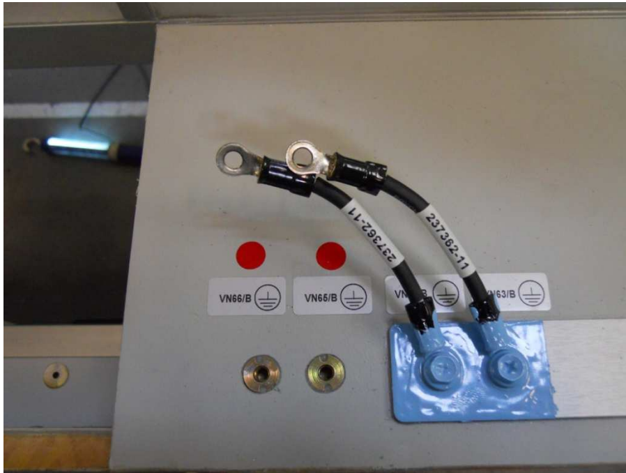
Obr. 19: Zabarvené spoje zemnicího pasu
