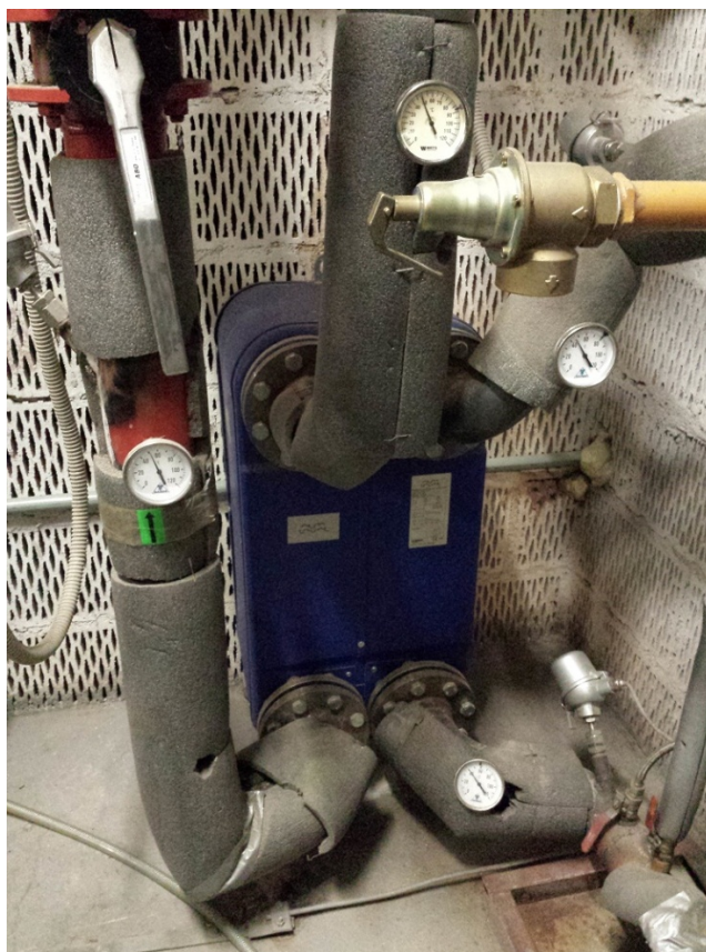
Příloha F: Tepelný výměník KGJ
