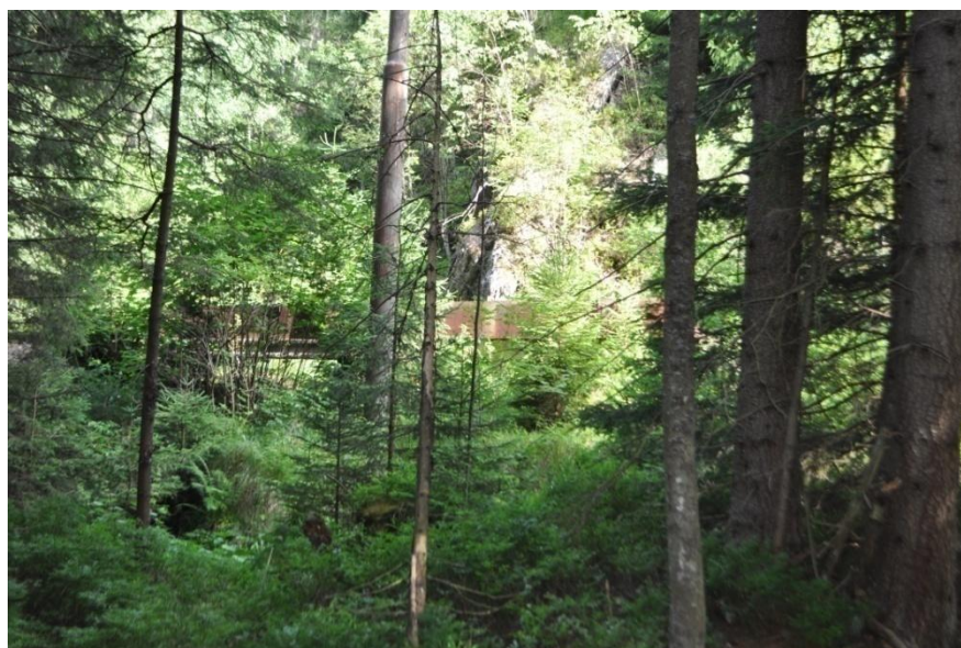
Obrázek 2-10: Ocelové koryto horního Úhlavského přivaděče
