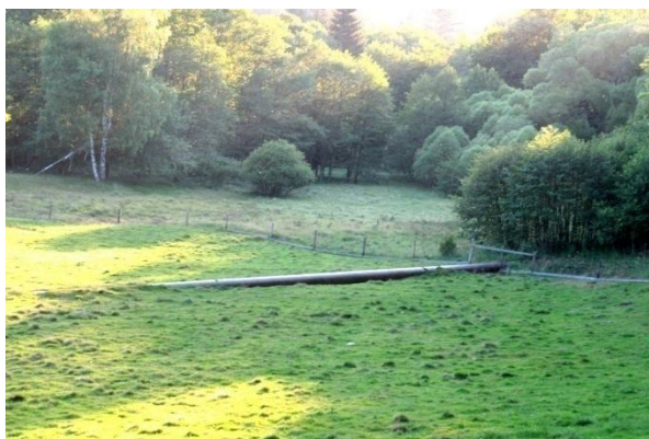
Obrázek 3-10: Začátek tlakového potrubí z Úhlavy pod penzionem U Císaře
