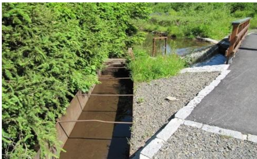
Obrázek 2-9: Začátek vodního kanálu u mostu nad elektrárenskou nádrží (pod Karlsmühlem)
