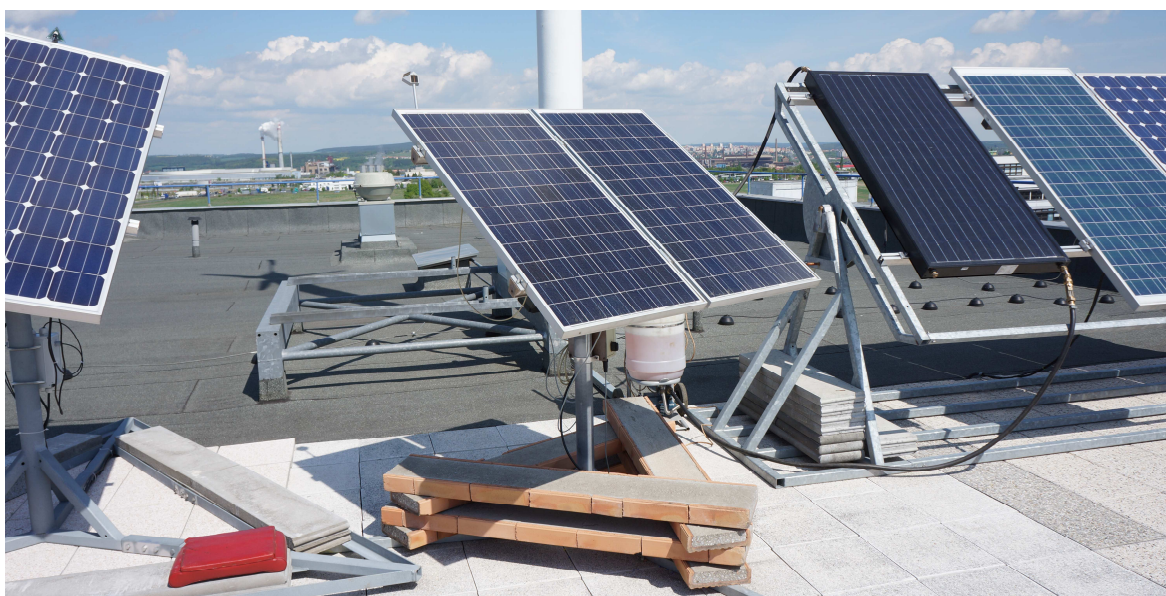
Obr. 16 - Dvouosý sledovač s dvěma polykrystalickými panely. P=200 Wp.
