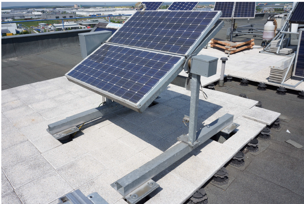
Obr. 21 - dva panely Isofoton I110 nainstalovány pod úhly 27° a 34°
