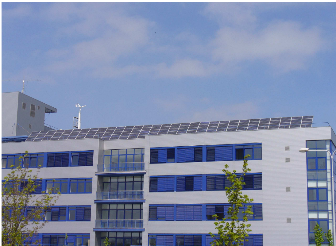
Obr. 9 - Fotovoltaický systém na budově Elektrotechnické fakulty, 20 kWp
