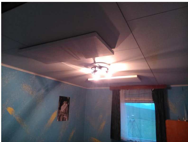
Obr. 20-6 Pohled na sálavé panely dětského pokoje od dveří
