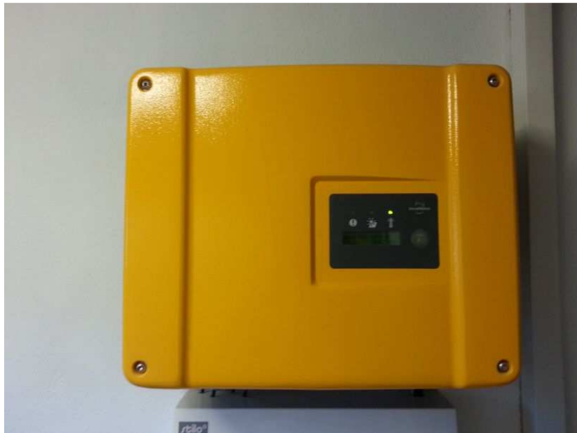
Obr. 6.4 Solární inverter Kostal Piko 5.5
