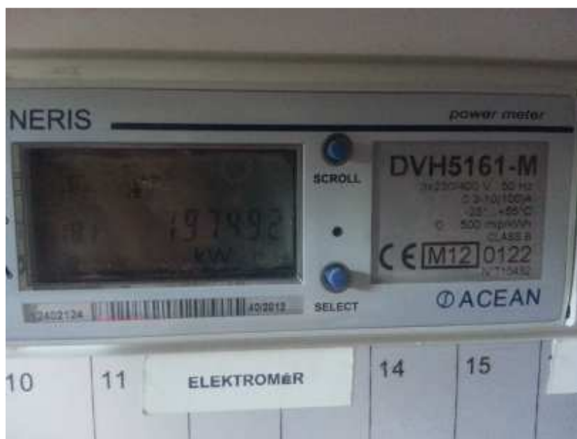
Obr. 6.7 Elektroměr NERIS DVH5161-M
