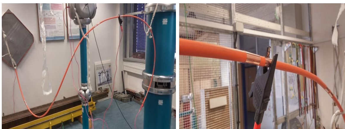
Obr. 3.6 Zavěšení kabelu (vlevo), detail zapojení elektrody (vpravo)
