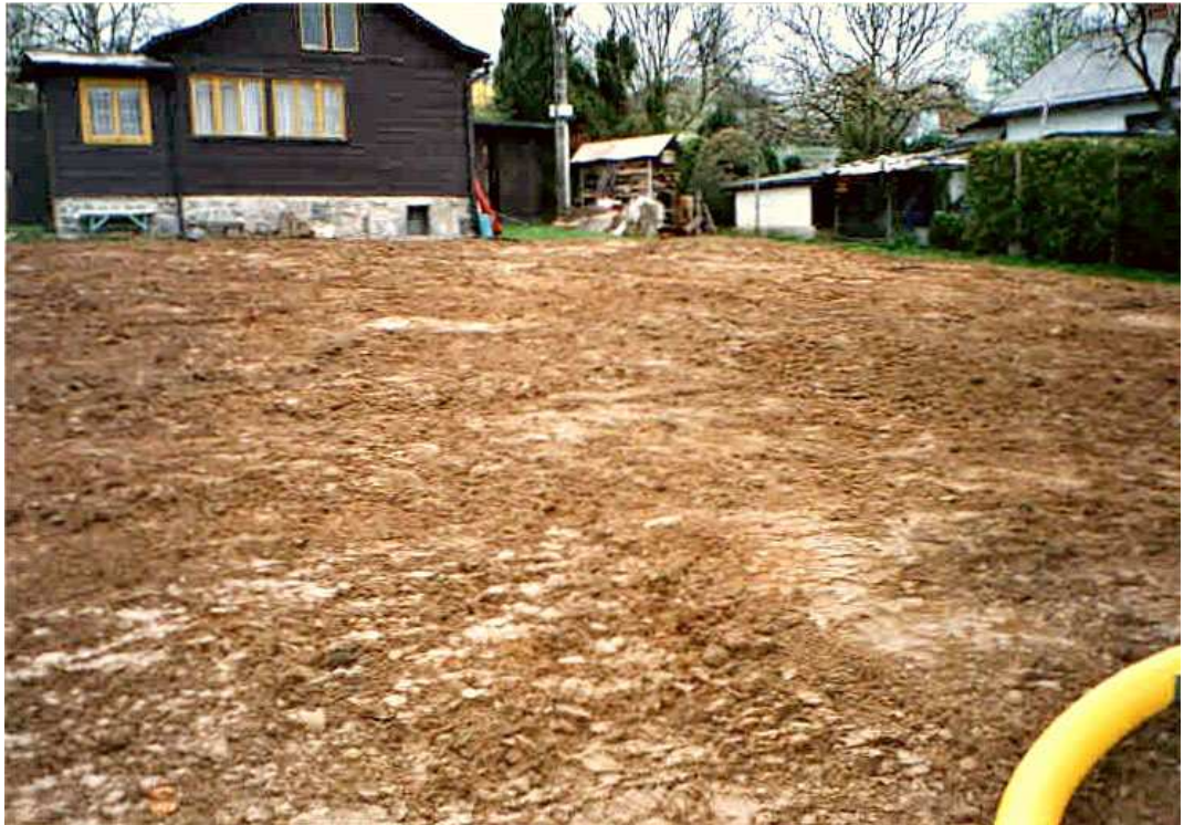
Obr. 9 – Plocha zemního kolektoru po zavezení výkopů. Zdroj: vlastní
