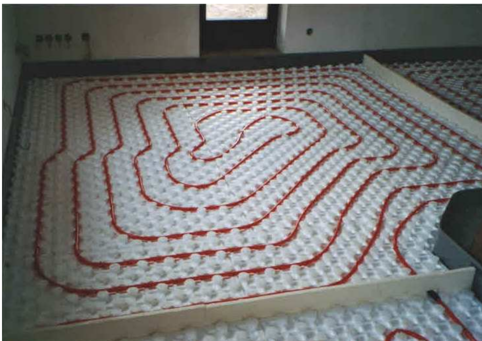
Obr. 7 – Systém vkládání podlahového topení, okraje opatřeny diletační páskou. Zdroj: vlastní
