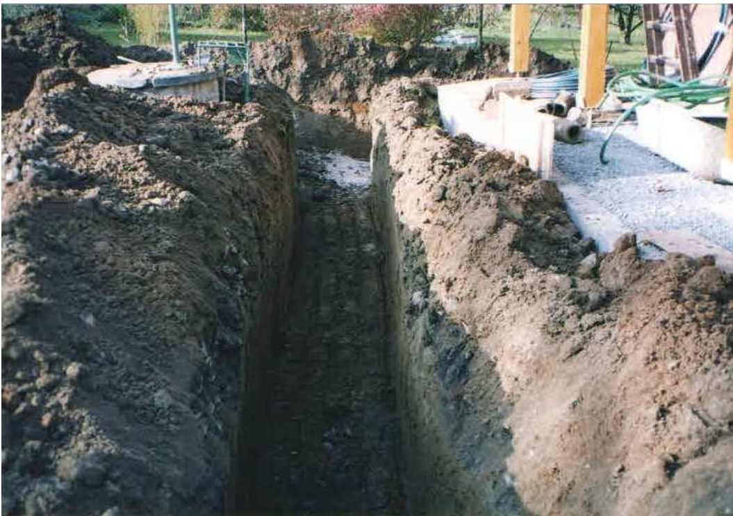
Obr. 4 – Zahloubení jako příprava pro plošný kolektor. Zdroj: vlastní
