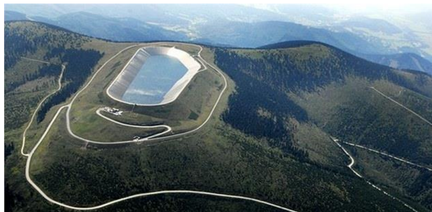
Obrázek č. 3: Přečerpávací vodní elektrárna Dlouhé stráně, převzato z [16]
