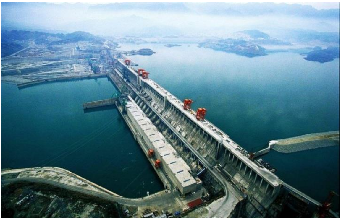
Obrázek č. 28: Největší a nejvýkonnější vodní elektrárna na světě, převzato z [29]
