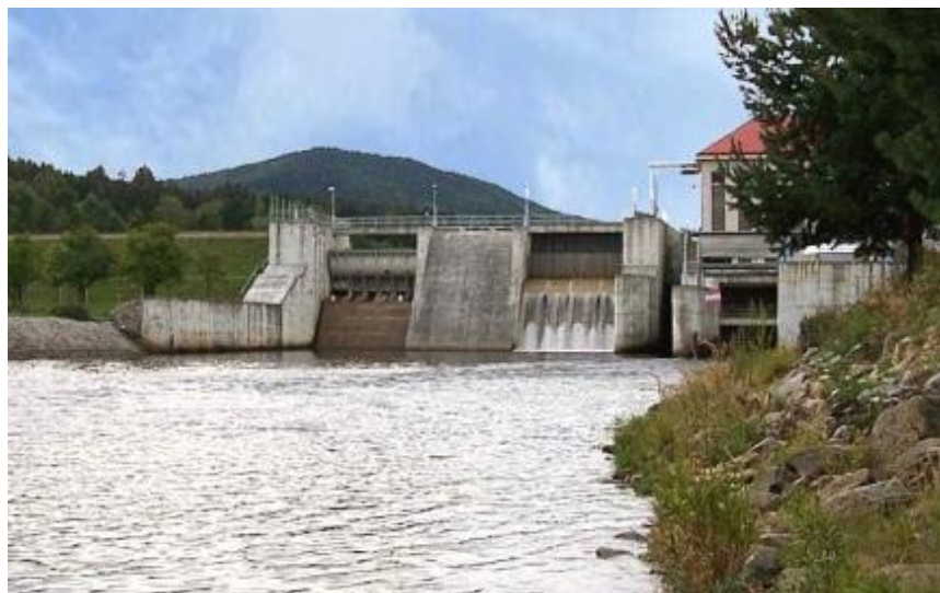
Obrázek č. 1: Průtočná vodní elektrárna Lipno II, převzato z [16]
