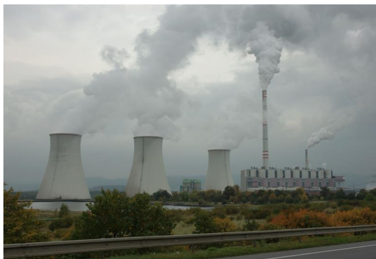
Obrázek č. 26: Elektrárna Prunéřov, převzato z [15]
