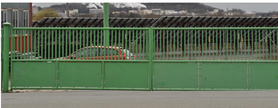
Obr. 3 Příjezdová vrata [Zdroj: vlastní]
