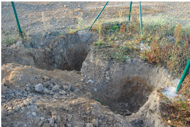
Obr. 14 Otvory pro upevnění bariér [Zdroj: vlastní]
