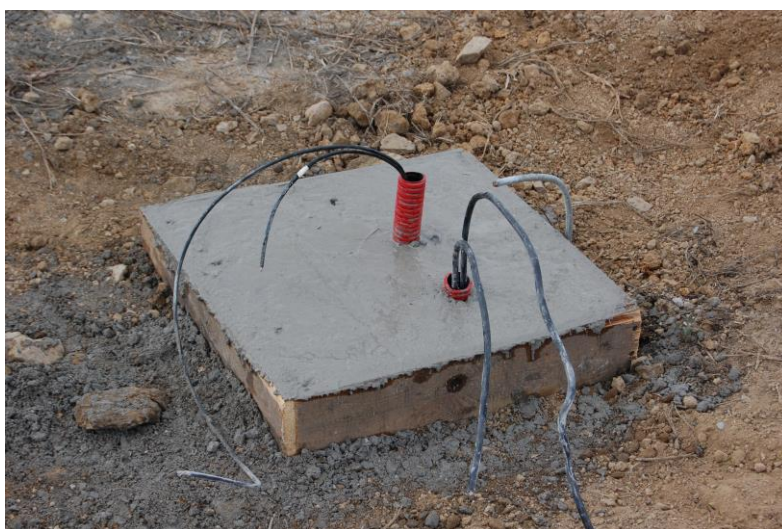
Obr. 15 Betonová podložka včetně kabelů a chráničů [Zdroj: vlastní]
