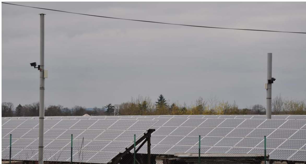
Obr. 11 Kamerový systém v objektu FVE [Zdroj: vlastní]
