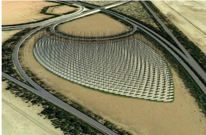
Obr. 2.4. Stéblková větrná elektrárna [9]
