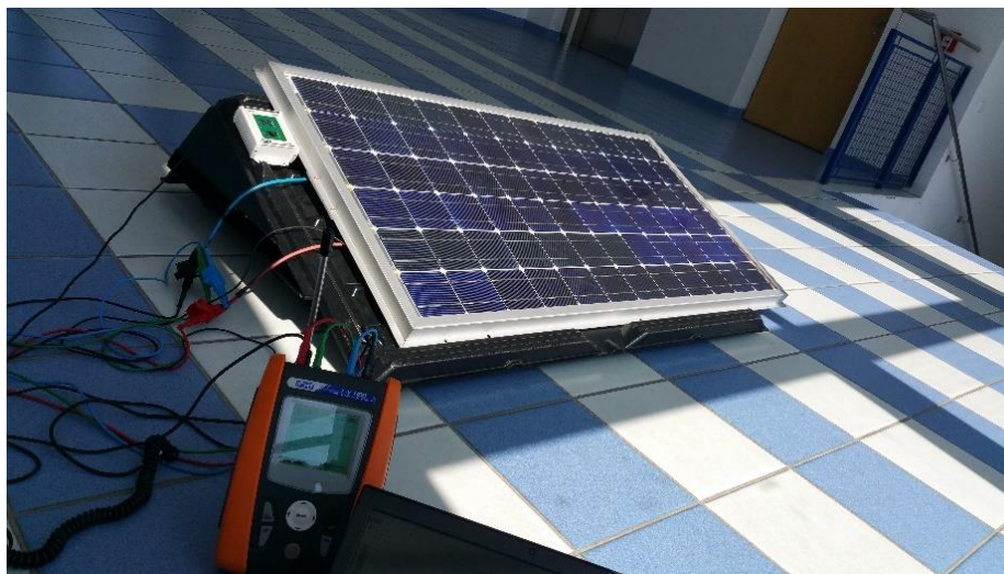
Obr. 2.8 Kontrolní měření ohřevu FV panelu Solartec SI 72-110 / 24 110WP uvnitř budovy ZČU FEL
