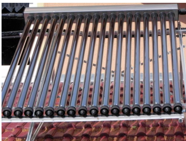
Obr. 19 Solární trubkový vakuový kolektor [30]
