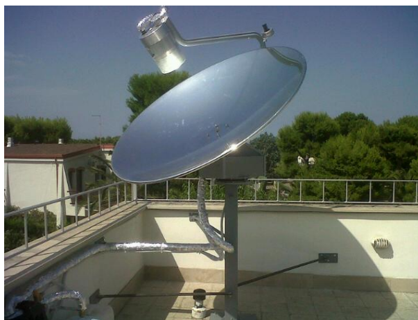
Obr. 20 Koncentrační solární kolektor [31]
