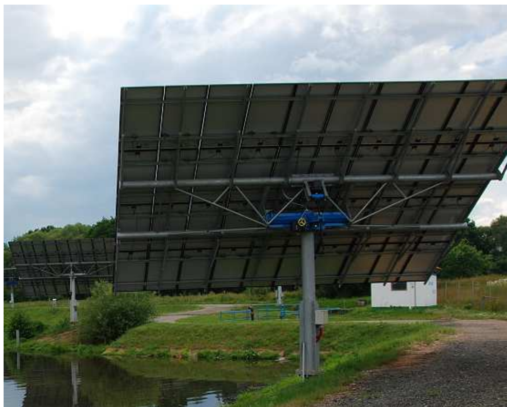
Obr. 3.: Mechanismus natáčení konstrukce elektrárny Černý Dub
