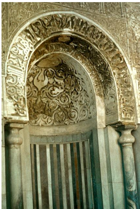
Obr. 18: Původní Džawharův mihráb. Detailní pohled na původní mihráb před rekonstrukcí, při níž v dolní části mihrábu byly odstraněny bílo-červeno-černé pruhy, které byly později nahrazeny bílými mramorovými deskami, viděnými na mihrábu dodnes.
