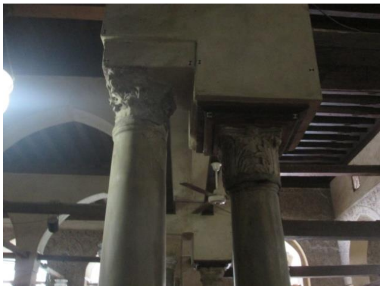
Obr. 36: Sloupy. Detailní fotografie příkladu využití různorodých sloupů, odlišných nejen svou výškou, šířkou, ale i dřikem či hlavicí, které se jako znovu využitě objevují v celém komplexu mešity.
