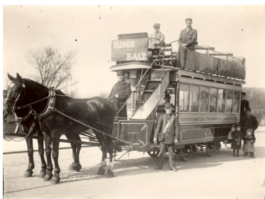
Obrázek 1-1 Koněspřežná tramvaj – exteriér [20]
