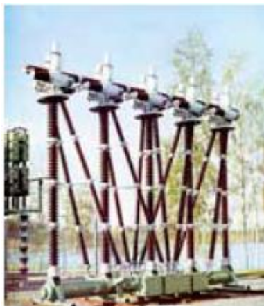
Obr. 1.1: Tlakovzdušný vypínač (převzato z [2]).
