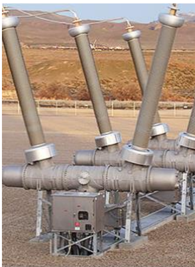
Obr. 2.12: Vypínač DT2-550 (převzato z [9]).
