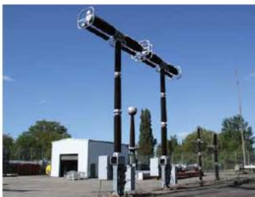
Obr. 2.8: Vypínač 3AP4 pro 800 kV (převzato z [7]).
