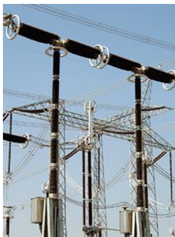
Obr. 2.11: Vypínač GL318 (převzato z [9]).
