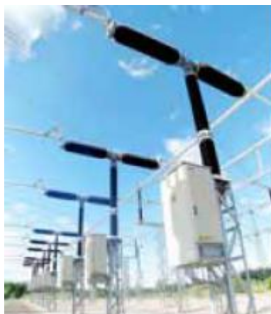
Obr. 1.3: Tlakoplynný vypínač s plynem SF 6 (převzato z [2]).
