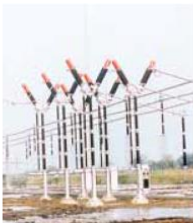
Obr. 1.2: Máloolejový vypínač (převzato z [2]).
