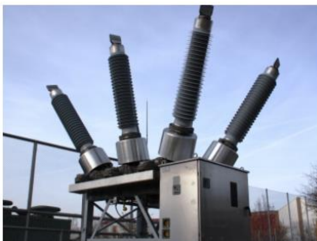
Obr. 2.9: Vypínač dead tank (převzato z [7]).
