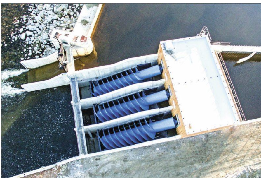
Obr. 3.9: vodní elektrárna se šnekovou turbínou (převzato z [30])
