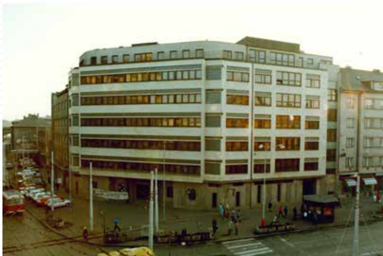
Fakulta sídlila v budově bývalého krajského výboru KSČ. Do současné se přestěhovala v roce 2006.
