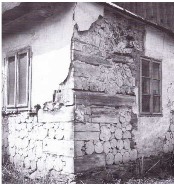
Obrázek 10-5 – Armatura u dřevostavby 79
