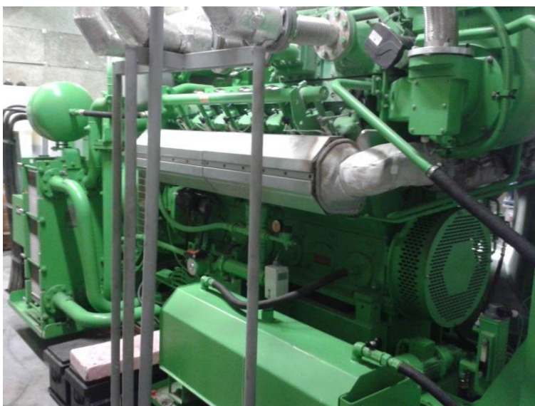
Obr. 7: Kogenerační jednotka [23]
