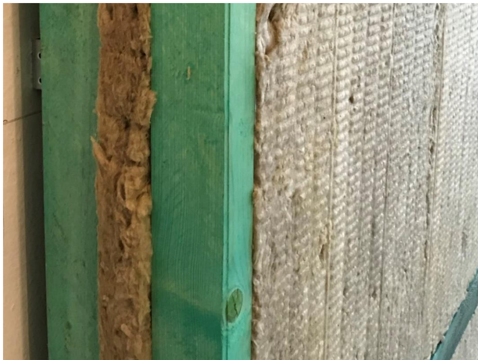
Obr. B. 6: Detail aplikace minerální vaty Knauff MPE – pohled z boku
