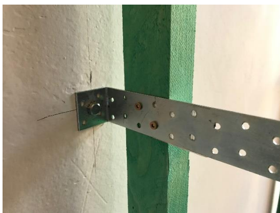
Obr. B. 3: Detail uchycení ke zdi
