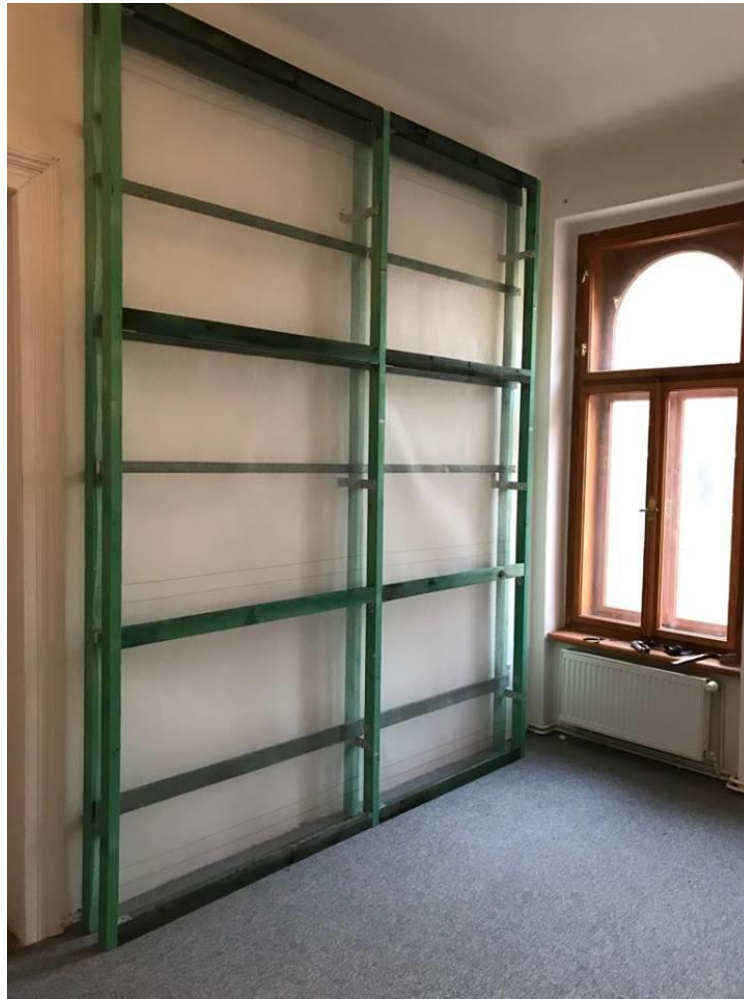
Obr. 6.13: Konstrukce navrženého Helmholtzova rezonátoru na levé stěně
