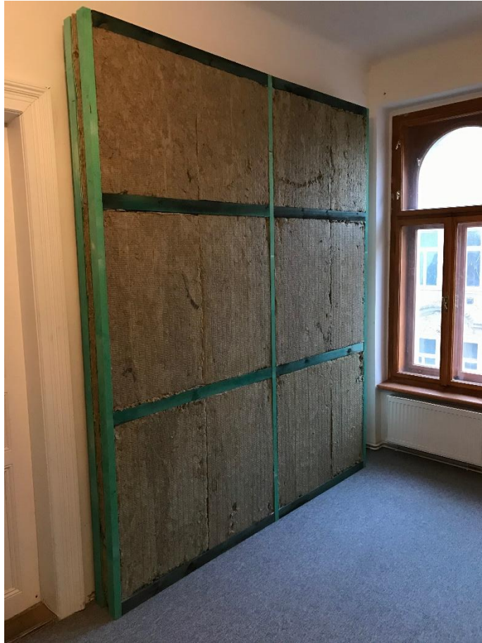
Obr. B. 5: Aplikace minerální vaty Knauff MPE
