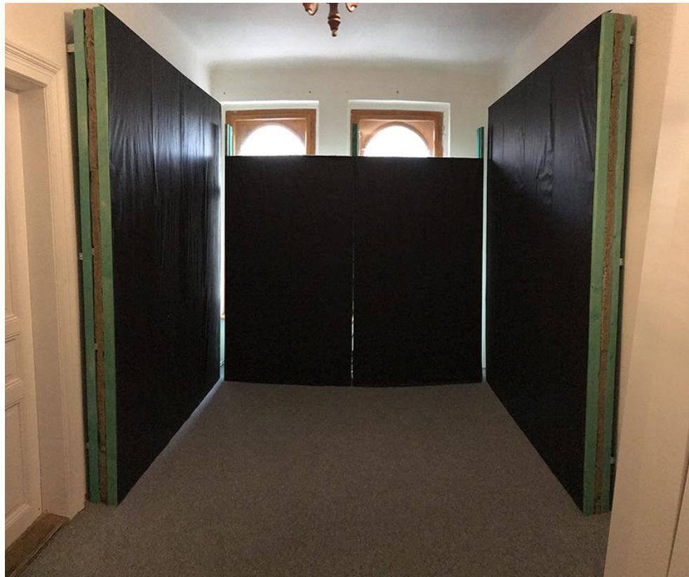
Obr. B. 8: Pohled na Všechny konstrukce po aplikaci netkané mulčovací textilie
