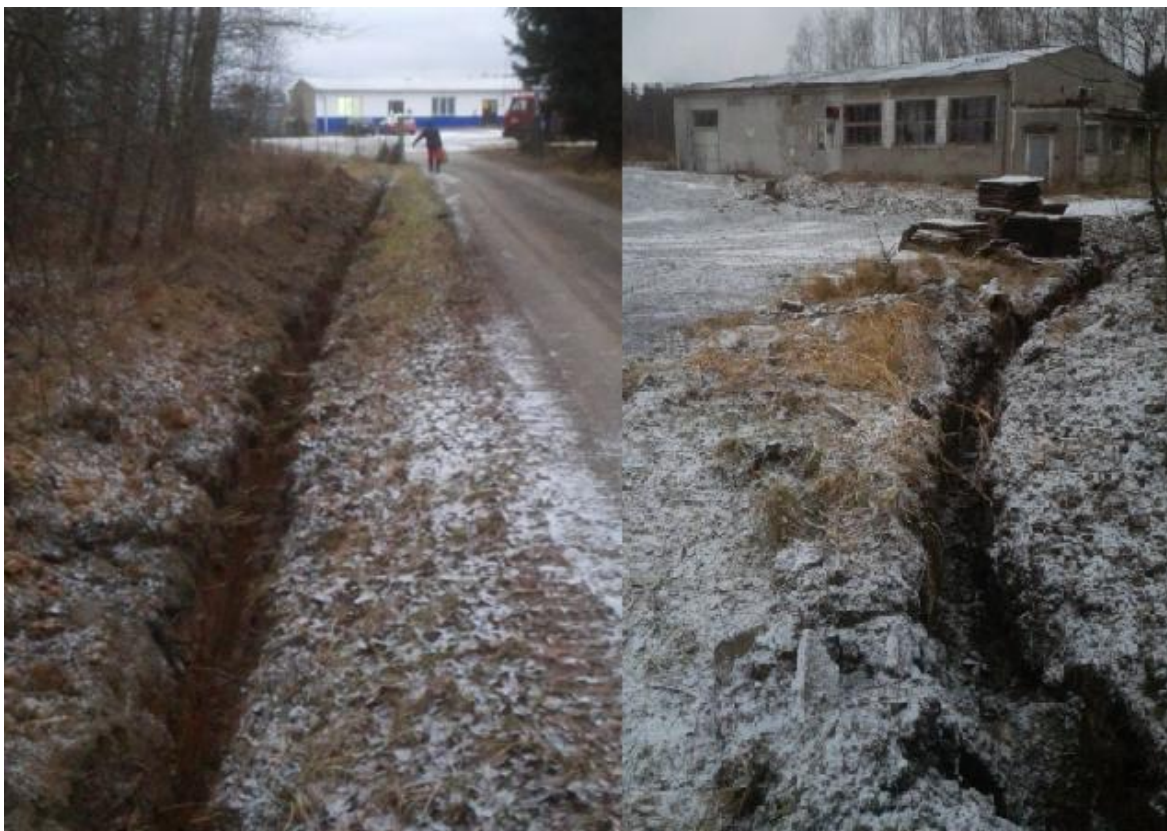
Obr. 28: Položení kabelu (levý obrázek – směr výrobní hala – pravý obrázek – směr k budově s hlavním rozvaděčem)
