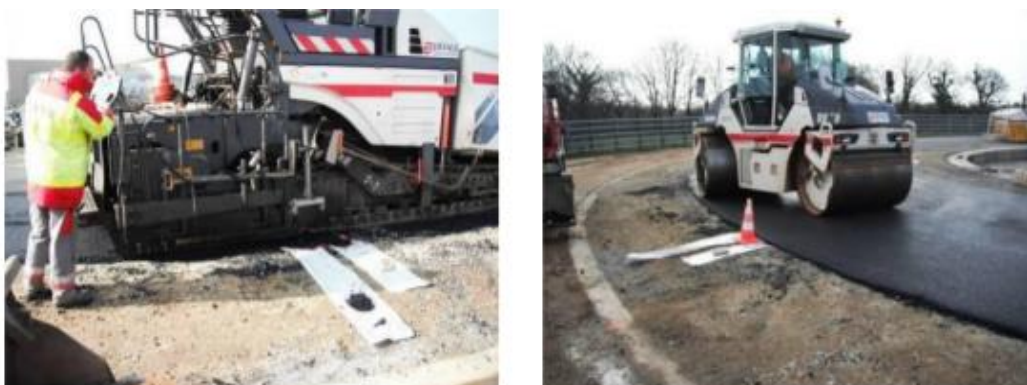
Obr. 69 Instalace geotextilních proužků pod 8cm asfaltu (převzato z [79])
