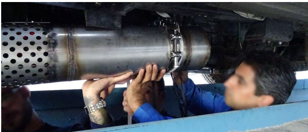
Obrázek 12-8 Instalace filtru v Iránské islámské republice
