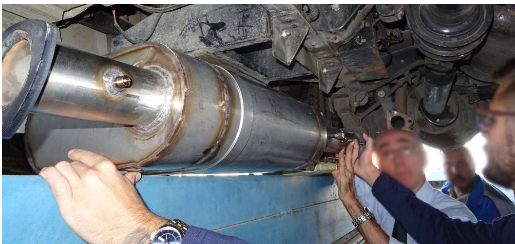
Obrázek 12-9 Instalace filtru v Iránské islámské republice
