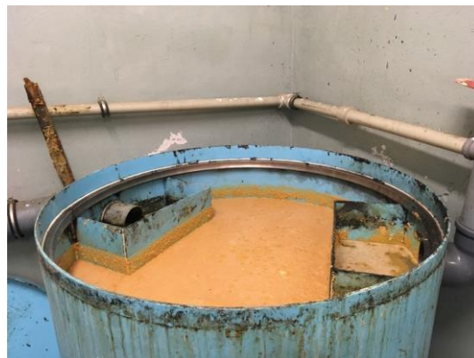
Obrázek 5 – Tuky a nerozpuštěné látky zachycené v lapáku tuku
