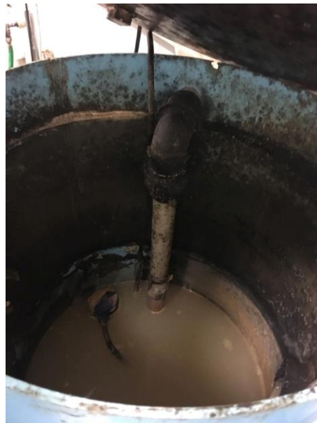
Obrázek 8 – Vyčištěná voda v čerpací jímce
