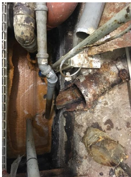
Obrázek 3 - Přítok odpadní vody z provozu kuchyně (detailní záběr)
