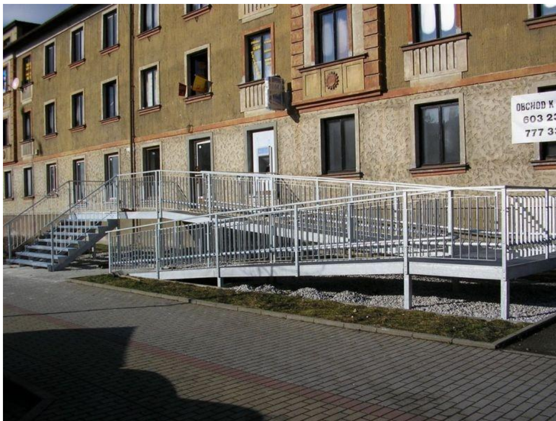
Obrázek 7: Ocelová konstrukce dodaná střediskem zámečnictví
