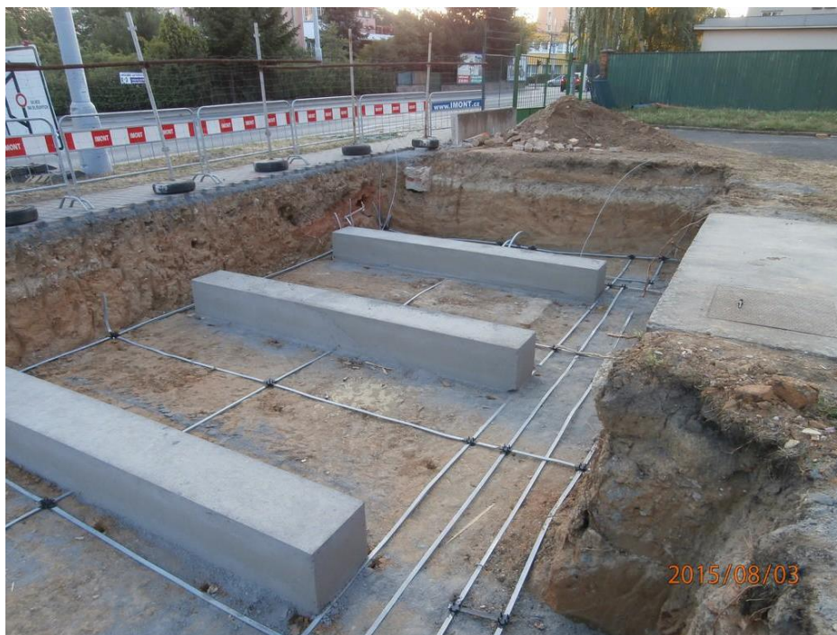
Obrázek 5: Zemní práce v Těšínské ulici, Plzeň
