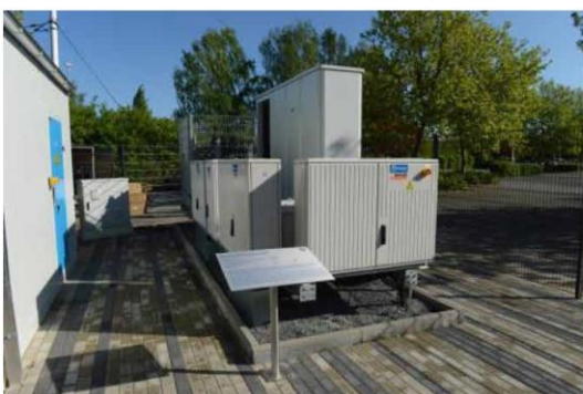
Obr. 10 – 1 MW SiC fotovoltaický střídač od GE a charakteristika jeho účinnosti [15]
