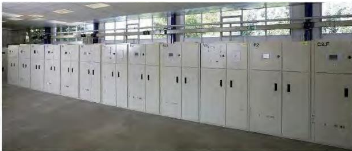
Obr. 2-2 Skříňový rozvaděč na straně 27 kV převzato z [6]
