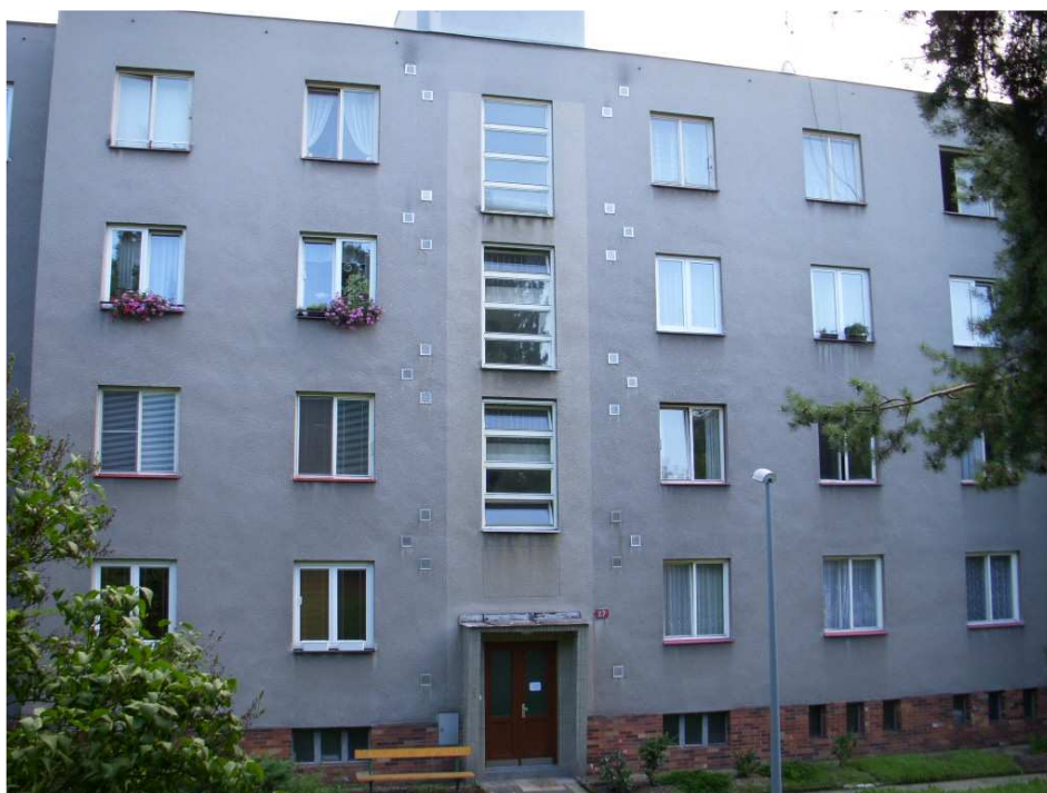
Obr. 5.1. Bytový dům č. p. 27 pohled ze severní strany
