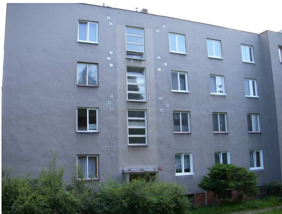
Obr. 5.2. Bytový dům č. p. 29 pohled ze severní strany
