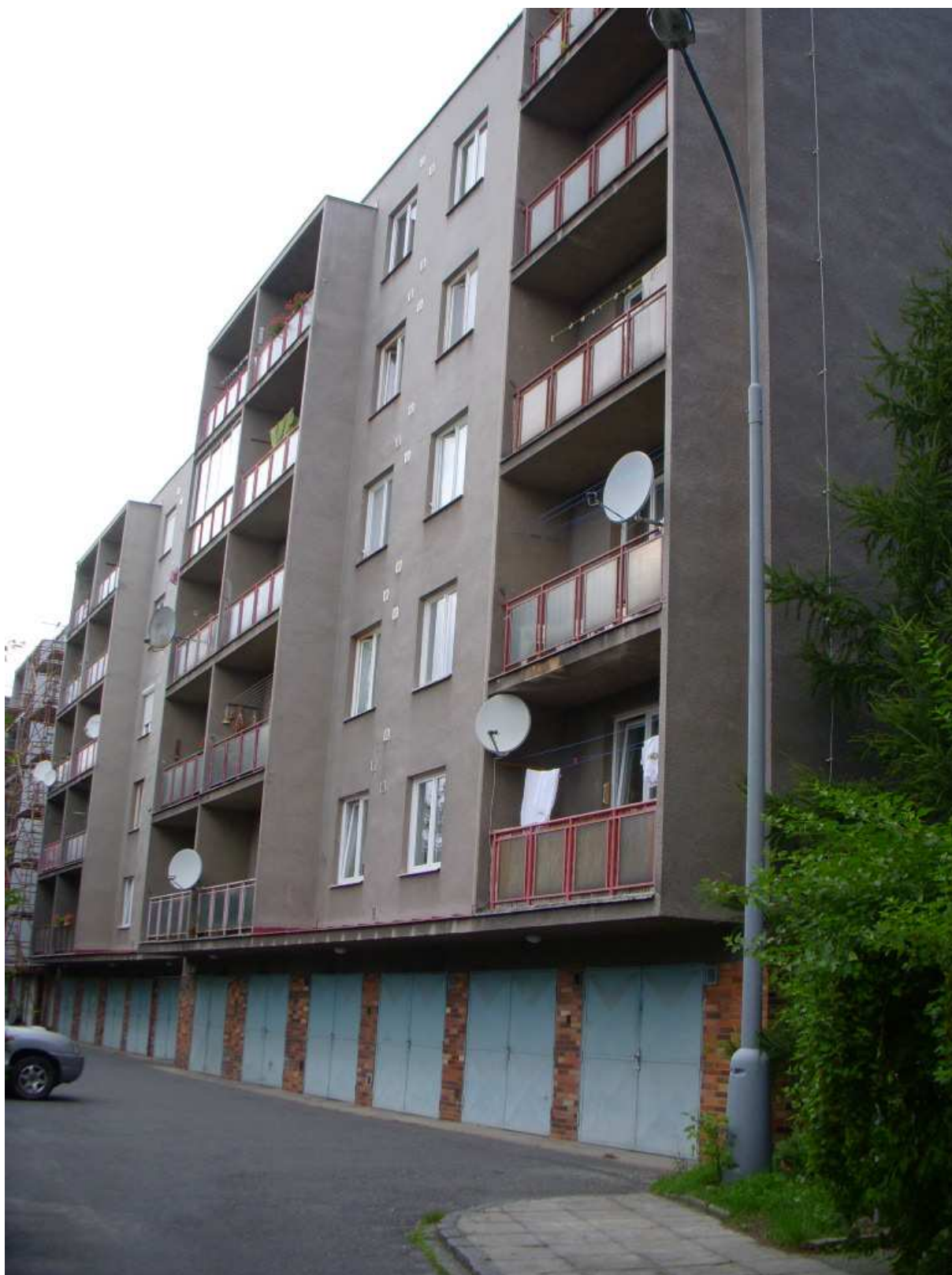
Obr. 5.4. Bytový dům č. p. 29 pohled z jižní strany
