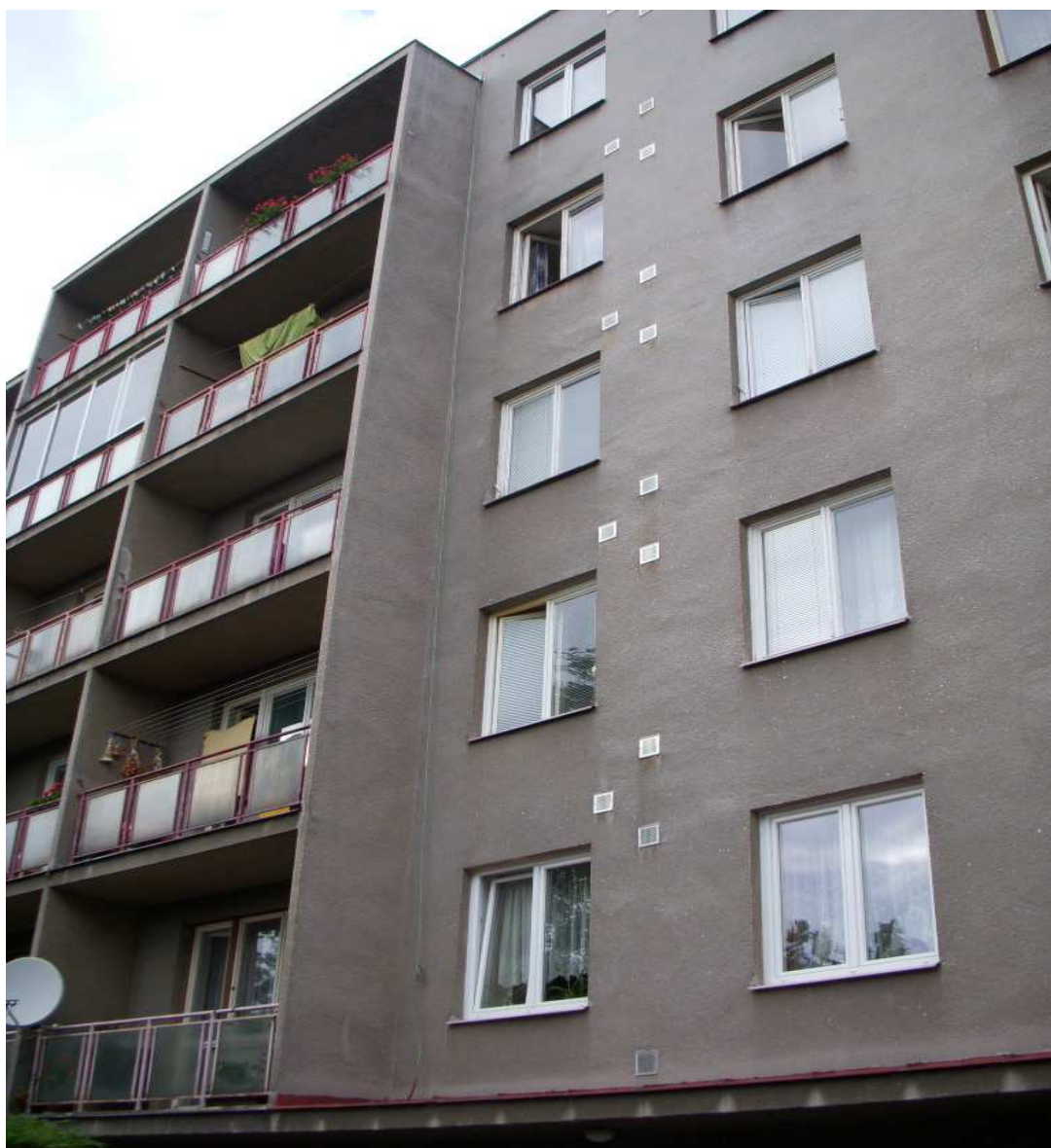
Obr. 5.3. Bytový dům č. p. 27 pohled z jižní strany
