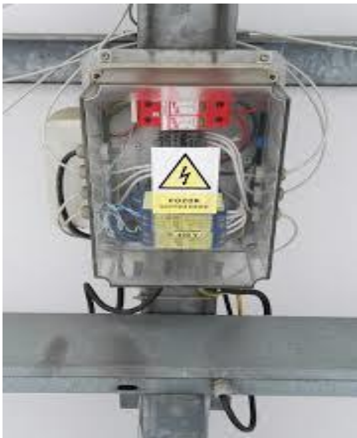
Obrázek 5 Připojovací skříň FVE [20]
