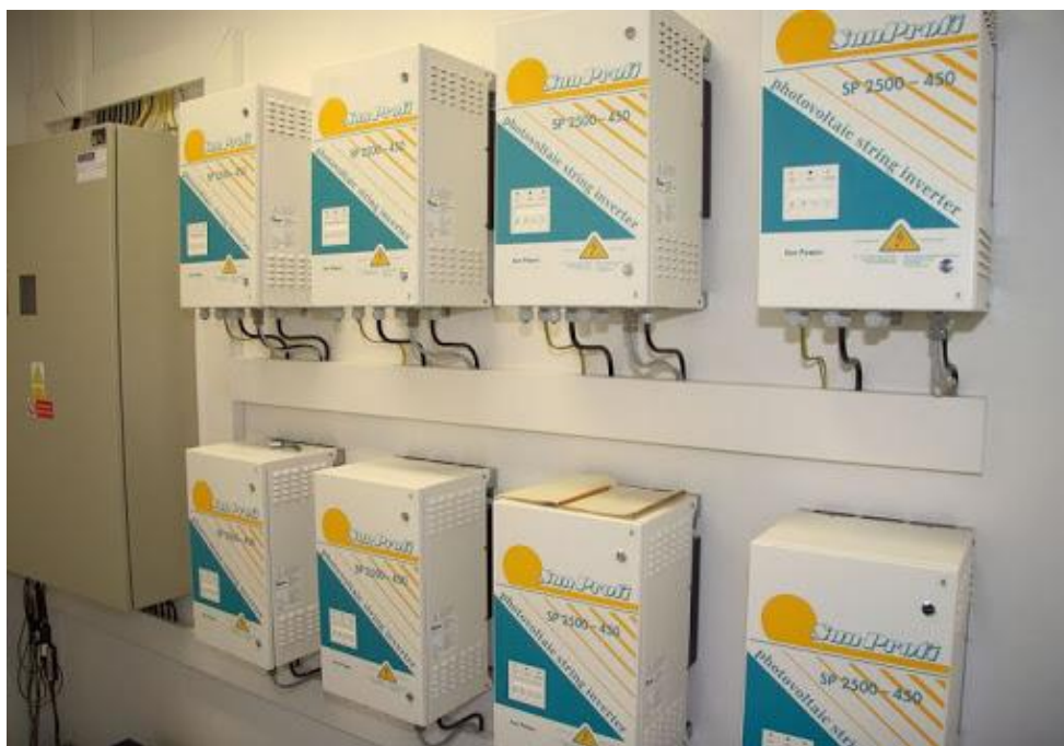
Obrázek 3 Střídače FVE [19]
