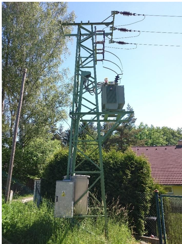
Obr. 7: Celkový pohled na příhradovou konstrukci s transformátorem [autor]
