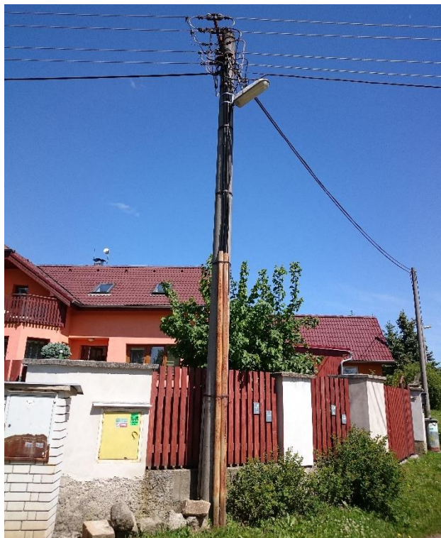
Obr. 10: Celkový pohled na první přechodový sloup [autor]
