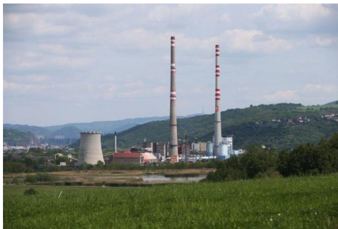
Obr. 1.1 Pohled na teplárnu Trmice [2]
