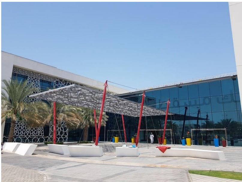
Budova Bank Muscat . Zdroj: vlastní fotografie autorky práce.
