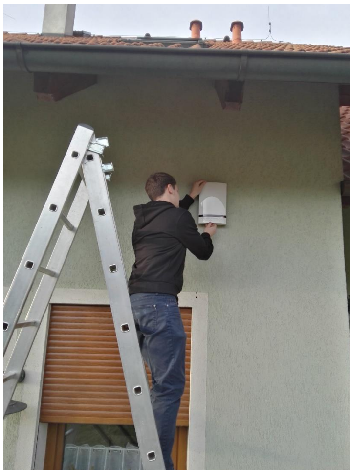
Obr. 5-9 Montáž venkovní sirény na venkovní fasádu domu
