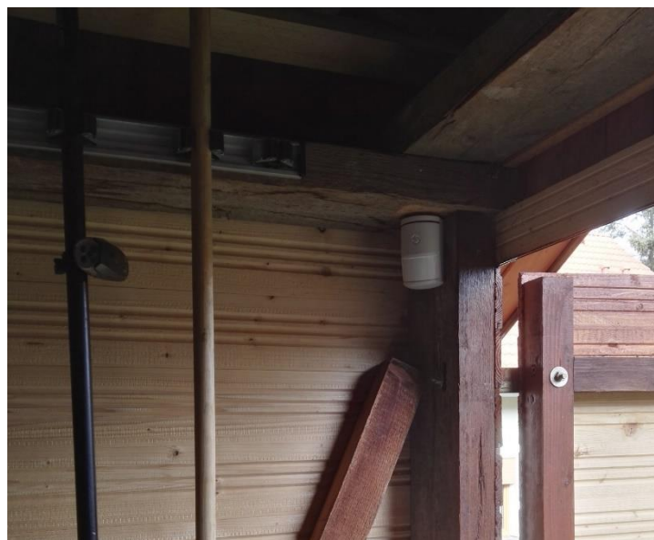
Obr. 5-21 Montáž detektoru v zahradním domku
