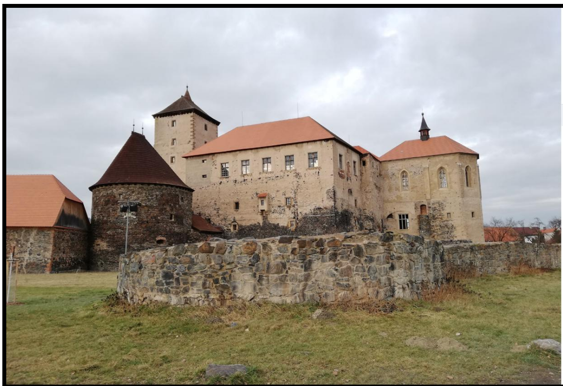
99. Švihov – pohled na jádro hradu se zbytky zbořeného vnějšího opevnění (v popředí)
