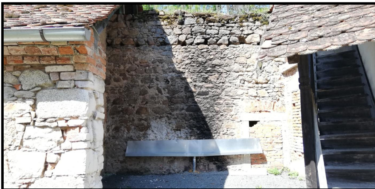
78. Zelená Hora – úsek severozápadní hradby předhradí
