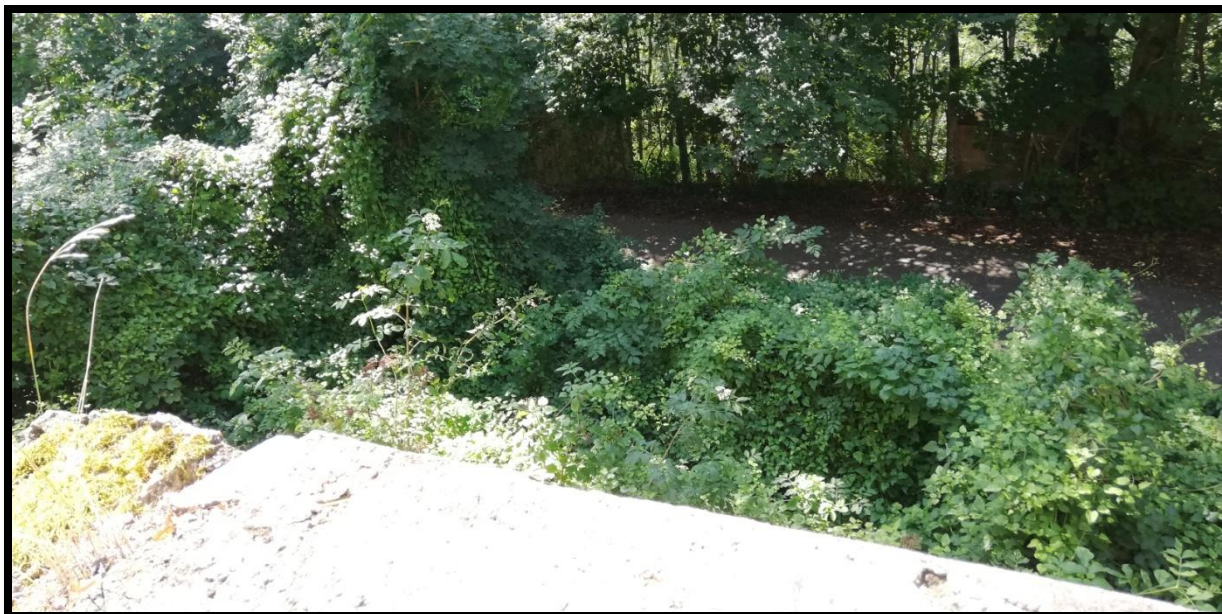
77. Zelená Hora – pohled na přístupovou cestu z hradby u válcové věže
