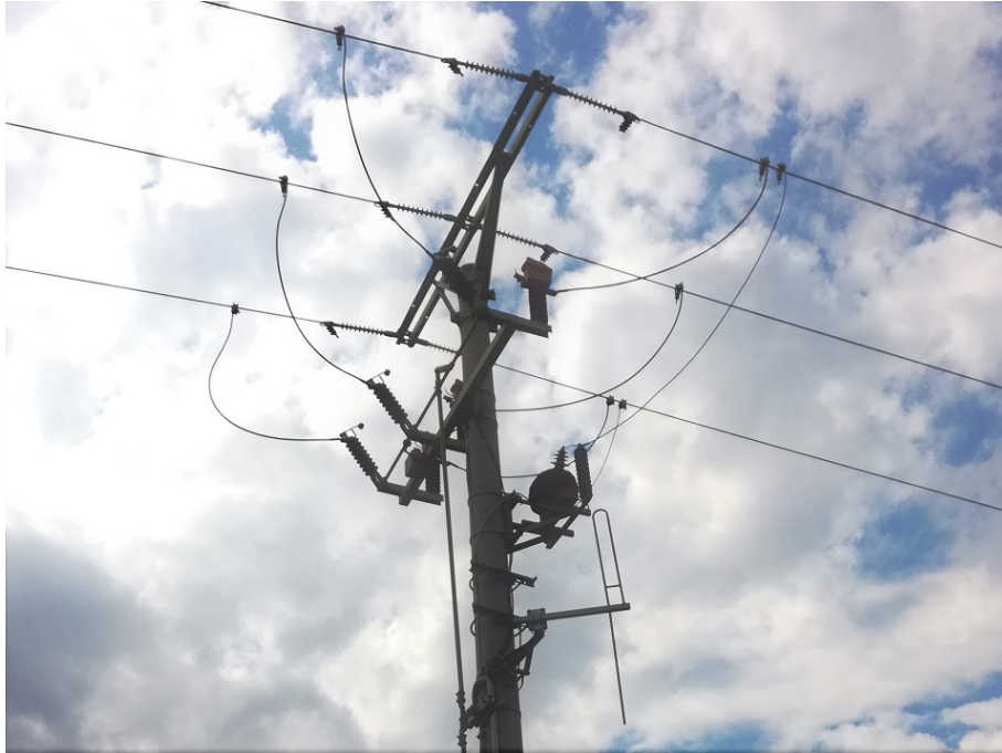
Obr. A.5: Dálkově ovládaný úsečník se zhášecí komorou na rozhraní vývodů (v rozepnutém stavu)
