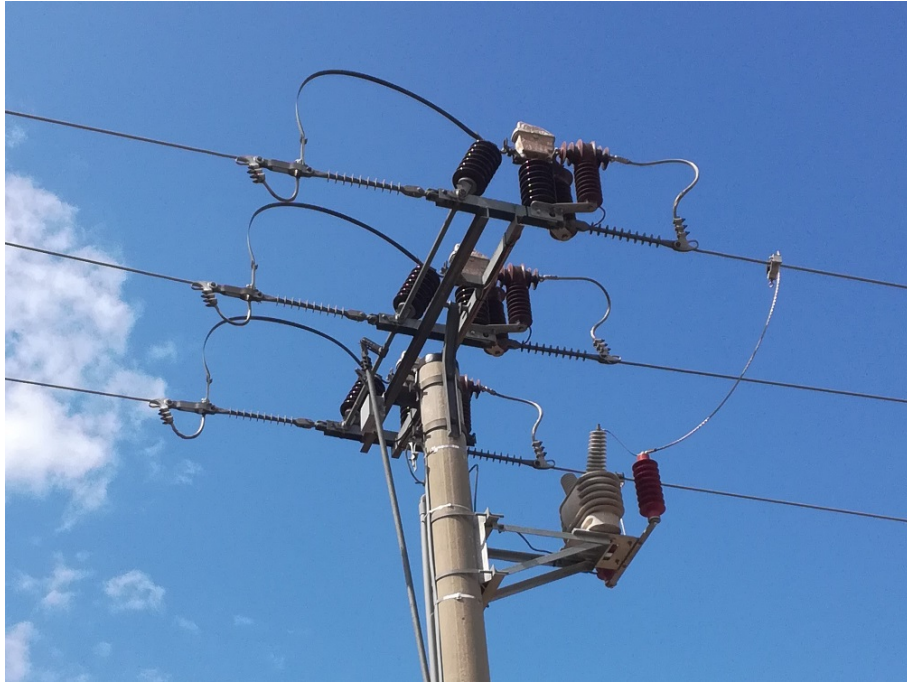
Obr. A.3: Dálkově ovládaný úsečník se zhášecí komorou a měřením U, I (na rovinné konzoli)
