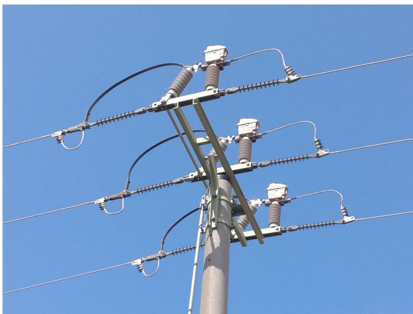
Obr. A.2: Úsečník se zhášecí komorou (na rovinné konzoli)
