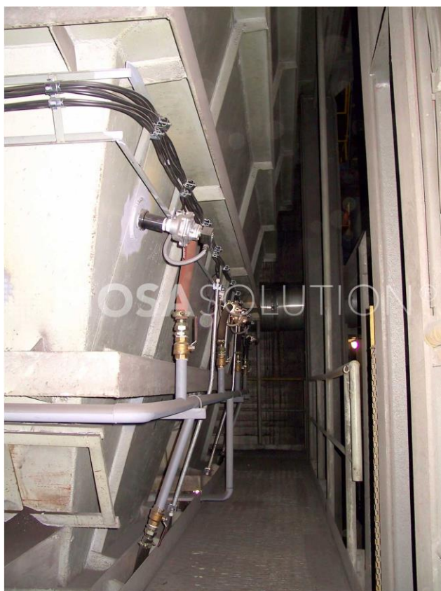
Obr. 7 – 2 Rozvody tlakového vzduchu [14]
