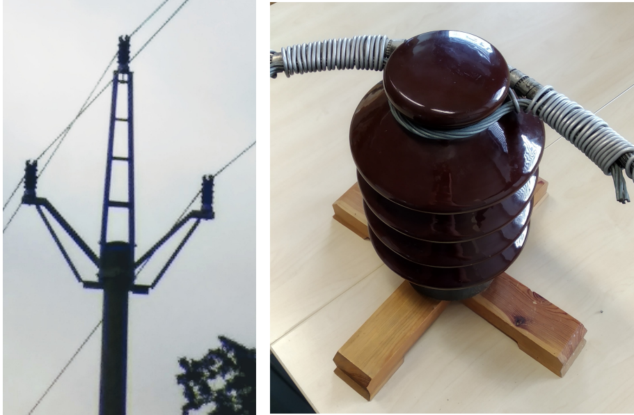
Obr. 1: Podpěrné izolátory na hladině VN
