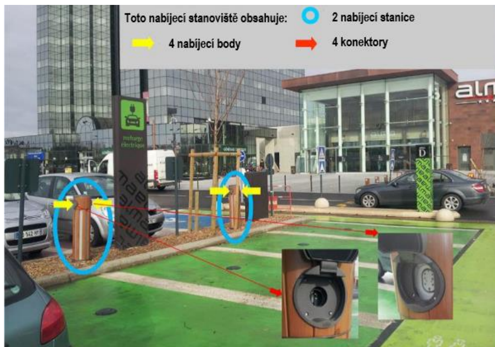
Obr. č. 12 - Dobíjecí stanice v praxi [25]
