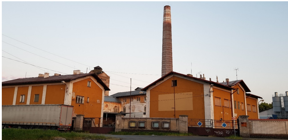
Obr. 50 Budovy bývalého Cukrovaru (Foto: autor)
