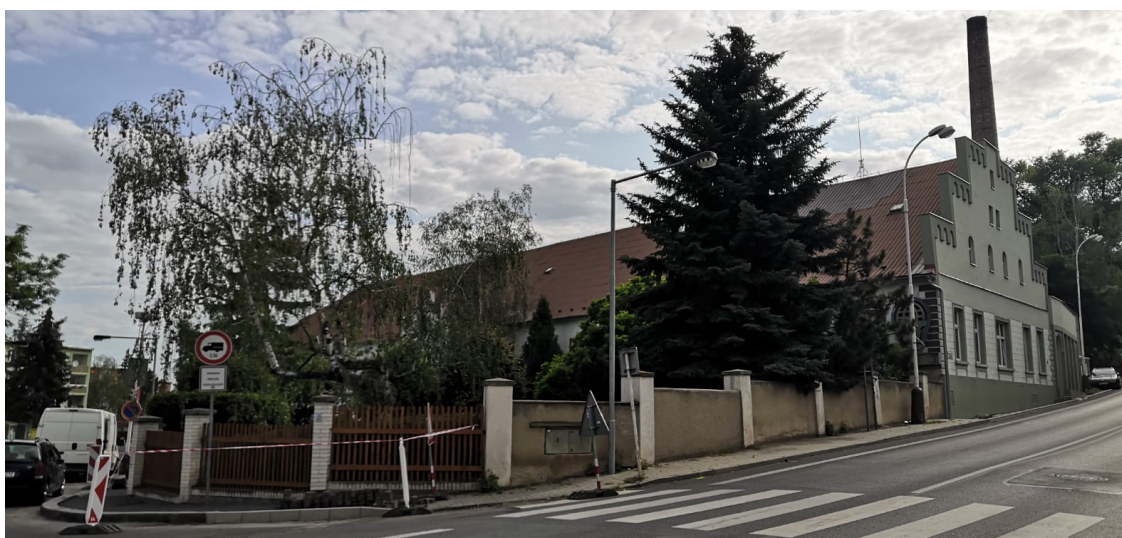
Obr. 32 Budova tehdejší Drátovny Telatko (Foto: autor)
