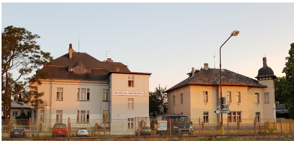
Obr. 40 Bývalá administrativní budova Šroubárny Žatec dnes louží jako ubytovna (Foto: autor)
