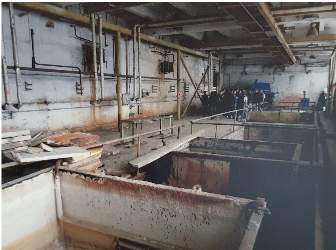
Obr. 47 Provozní hala po zastavení výroby z roku 2012 (Foto: Archiv RMŽ)
