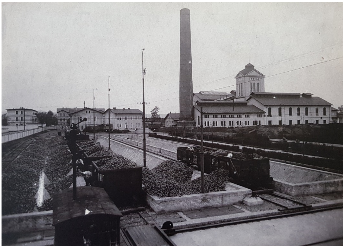
Obr. 49 Železniční vlečka v Žateckém cukrovaru, počátek 20. století (Foto: Archiv RMŽ)
