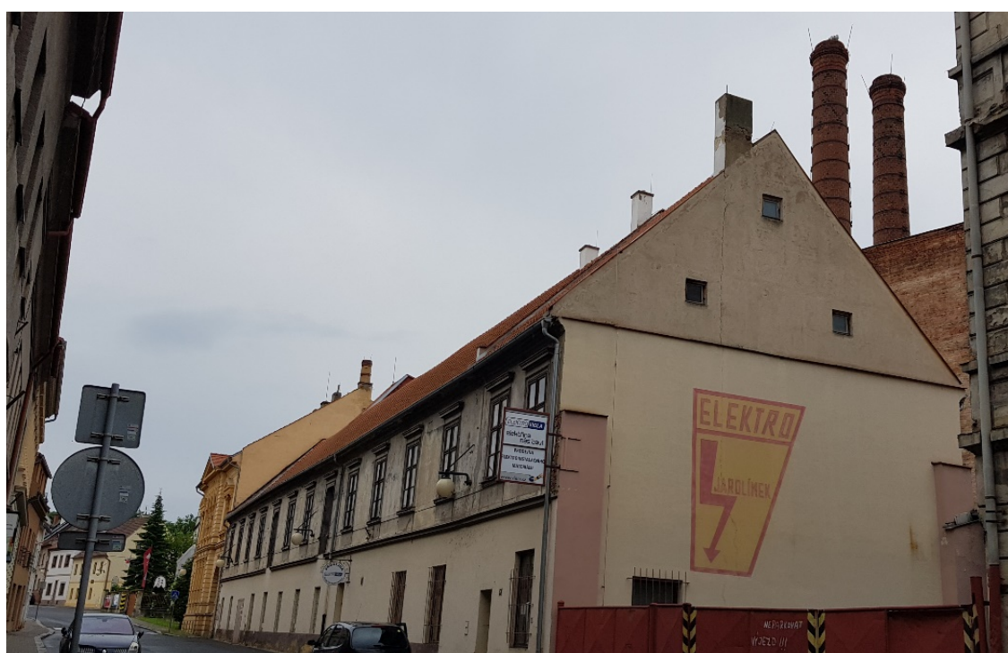
Obr. 2 Sušárna se dvěma komíny v Tyršově ulici (Foto: autor)
