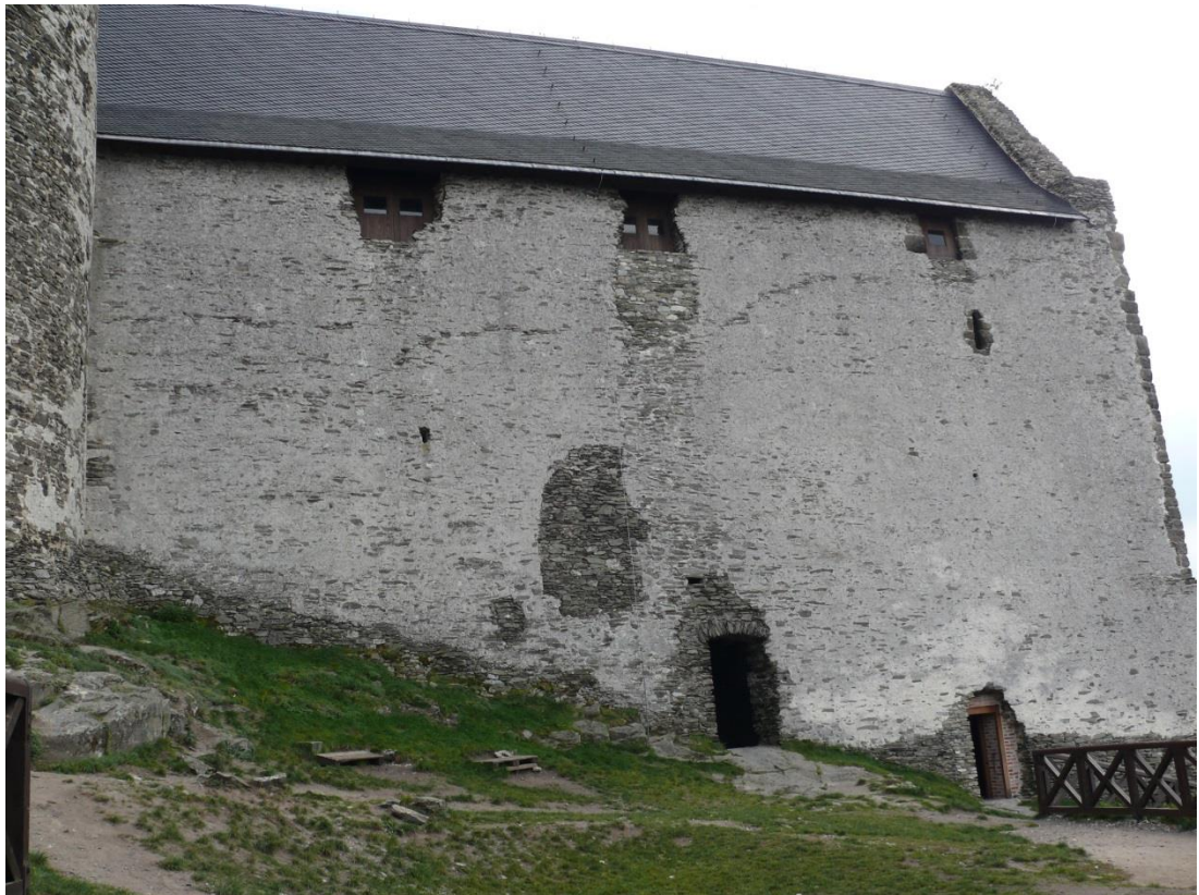
Obr. 86. Bezděz. Zazděný původní vchod do paláce na dolním hradě (foto autor 2019)
