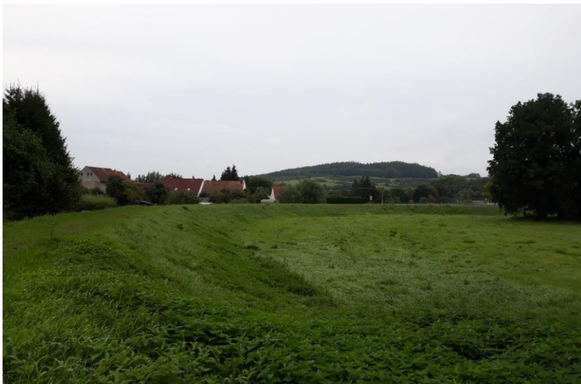
Obrázek 3 – Protipovodňová hráz ve Švihově (2020)
