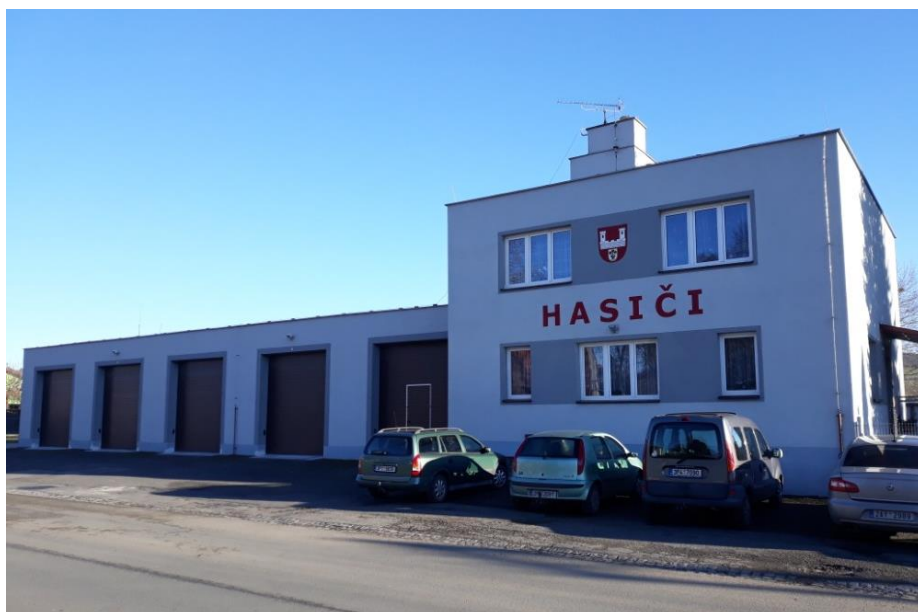
Objekt sídla SDH Švihov ve Švihově (2020) Zdroj: autor, 2020
