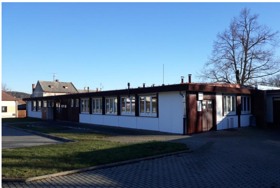
Objekt zdravotního střediska ve Švihově (2020) Zdroj: autor, 2020
