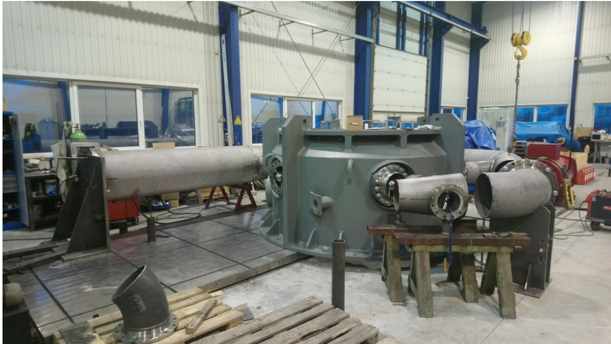
Obr. 2-3 Montáž Peltonovy turbíny [vlastní zdroj]
