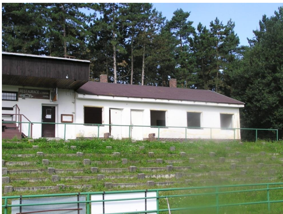
Obrázek 1: budova severní části šaten před zbouráním, Třemošná 61
